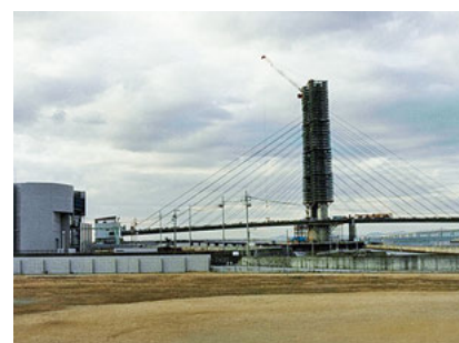
[平成6年] 田尻スカイブリッジ建設時の様子
