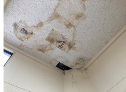
漏水しているようす
