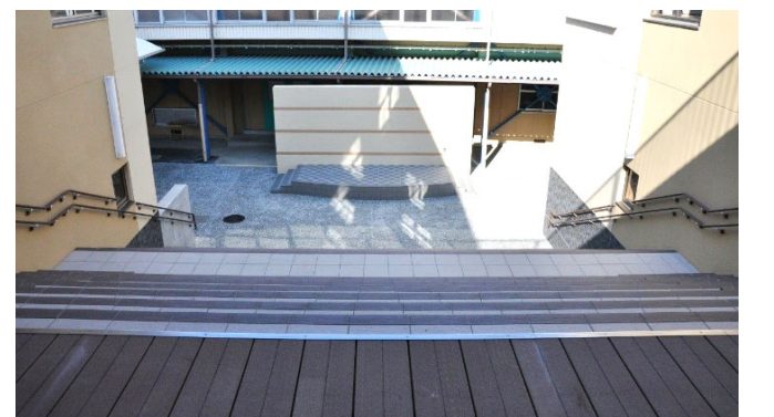
屋外階段ホール(2階から)
