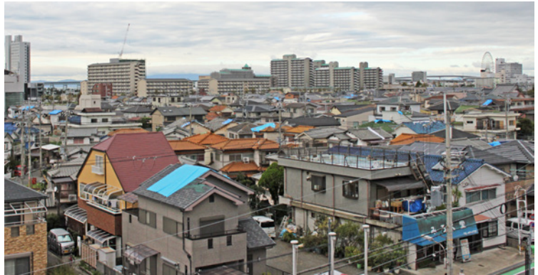
屋根瓦が飛ばされるなどの被害が多数発生し、ブルーシートでの応急処置が見られた（9月10日）
