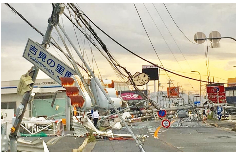
暴風によりなぎ倒された電柱など【主要地方道泉佐野岩出線（63号線）】
