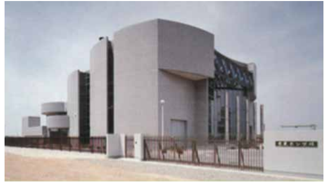
田尻町公共下水道 吉見ポンプ場
