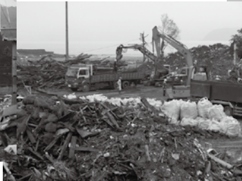
(少ない重機での作業)
