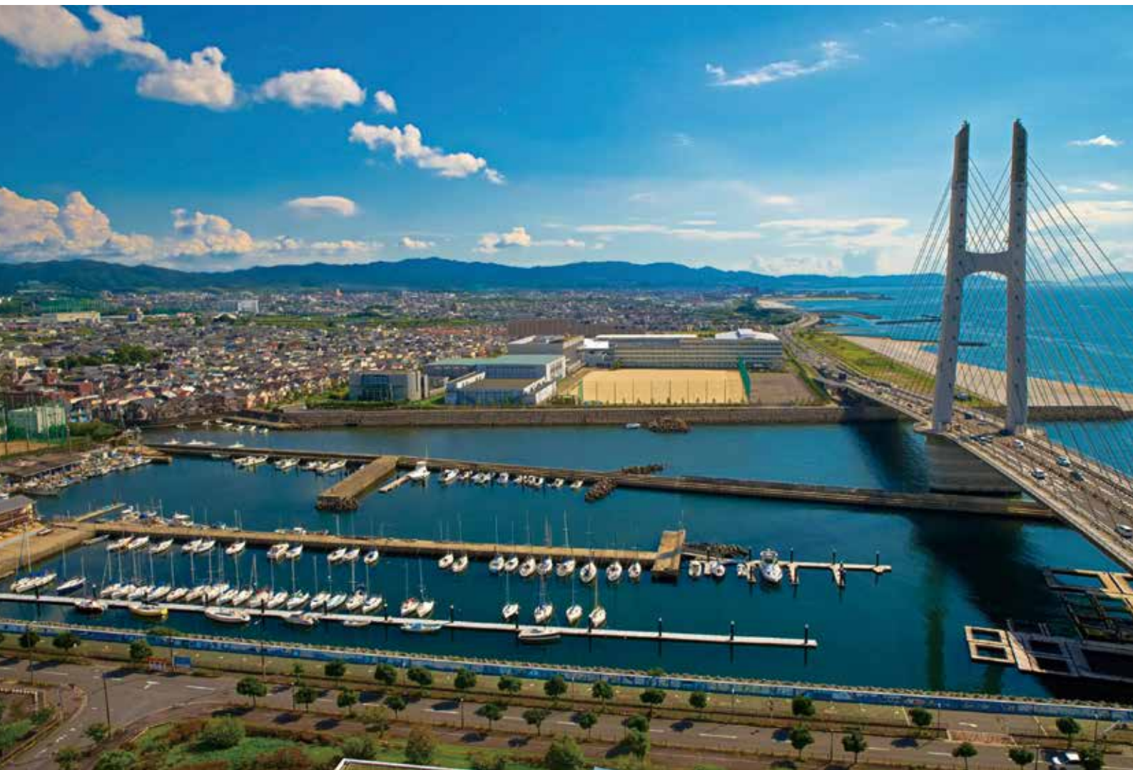
国際交流基金 関西国際センター 屋上より (議会だより広報委員会 射場 隆裕 委員長 撮影)
